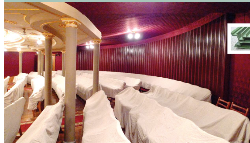
Panele dyfuzyjno-dźwiękochłonne w Operze Lwowskiej
