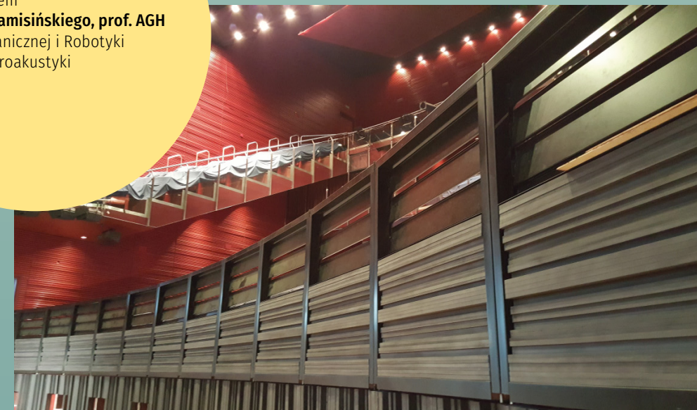
Ścianka czołowa orkiestronu w Operze Krakowskiej – regulacja ekranowania i odbicia dźwięku przez elementy bariery
