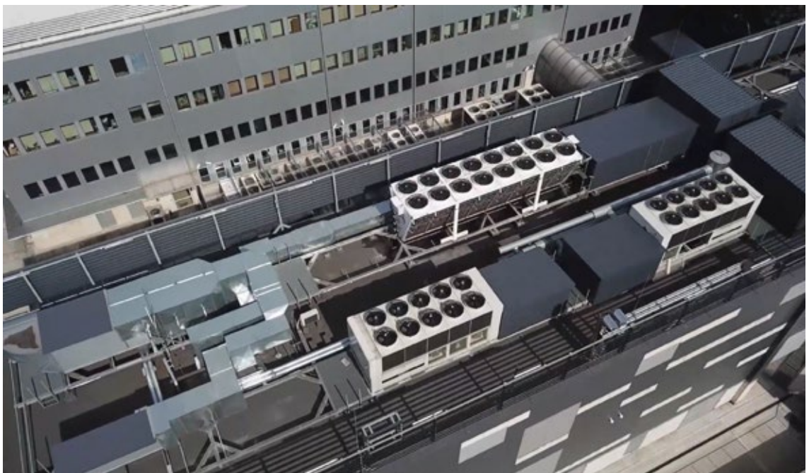
Fot. archiwum ACK Cyfronet (urządzenia do chłodzenia superkomputerów)
